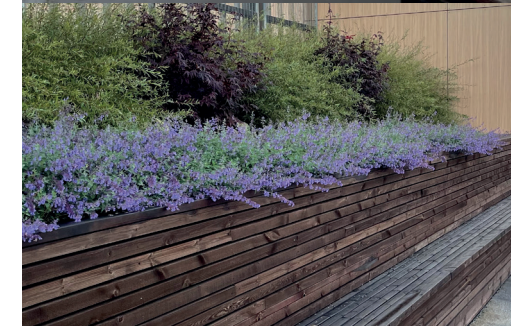
Takhage/takterrasse, Tønsberg psykiatri
