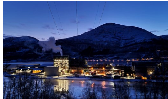
Elkem Salten har installert ny renseteknologi som produserer gjenvinningskraft i smelteverket.
